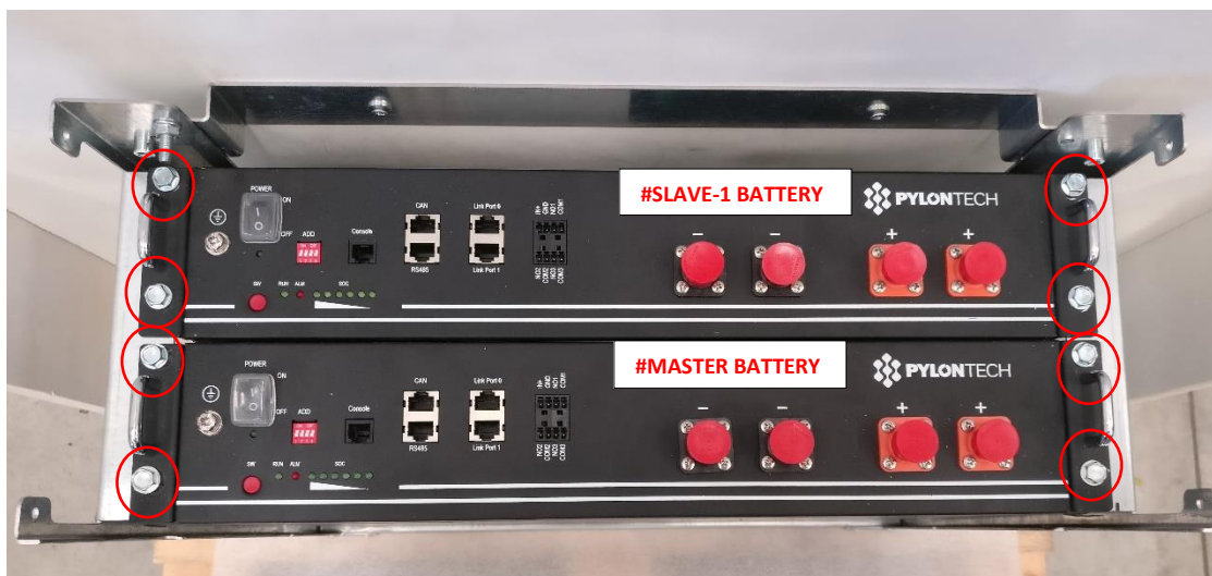
Figura 10 – Fissaggio moduli batteria al box batteria
